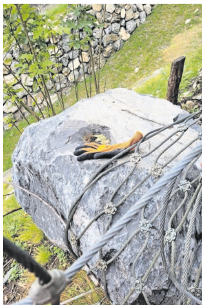
Im Gebiet Gumpisch kam es am vergangenen Freitag zu Aufschlägen von Steinen in den Schutznetzen oberhalb der Axenstrasse.
